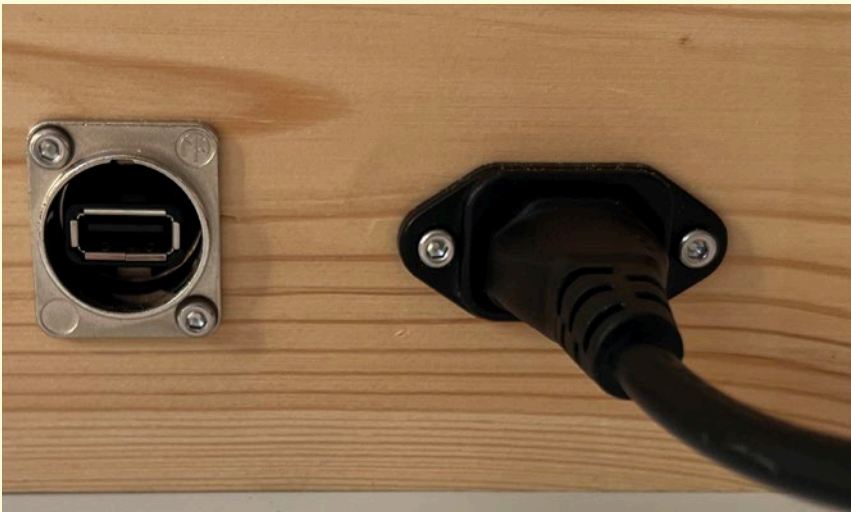
El cable IEC dará energía eléctrica al Sonògraf
